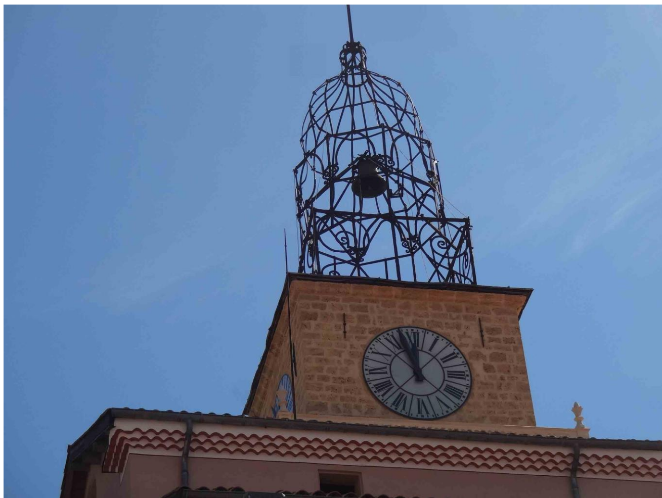
Le clocher a été surélevé en 1619 et doté d'un campanile en fer forgé de J et J . Grenon. La cloche de la ville y est suspendue depuis 1618 .
